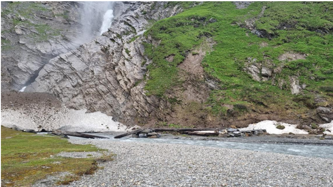
durch Schnee beschädigte Brücke beim Wasserfall im Frühsommer 2024
